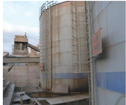
Fotoğraf 17 – Atık Yağ ve Fuel oil No. 4 Depo Alanı
