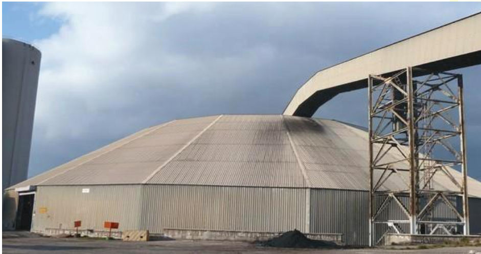
Fotoğraf 2 – Ham Kömür Konveyör Bandı Holü ve Stokhol Bağlantısı
