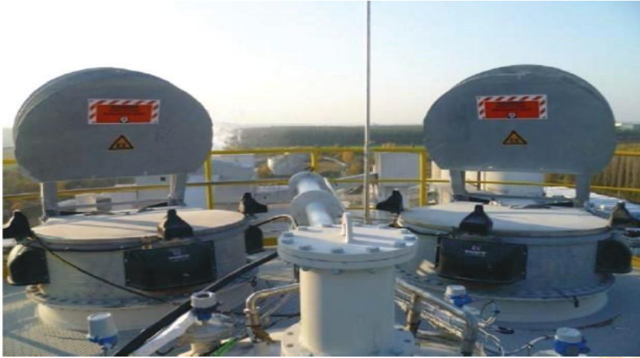
Fotoğraf 11 – Silo Üzeri Patlama Kapakları (Kendinden Kapanan ve Vakum Kırıcılı) 23
