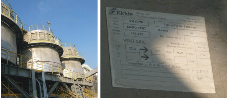
Fotoğraf 8 – ATY Silolarında Kullanılan Patlama Kapağı Örneği ve ATEX Sertifikası
