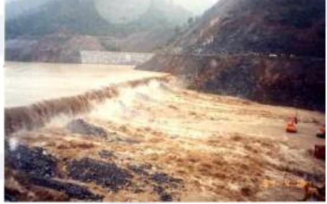
Őekil 14 - İnŐaat Halindeki Hidroelektrik Santrali TaŐkın Görüntüsü
