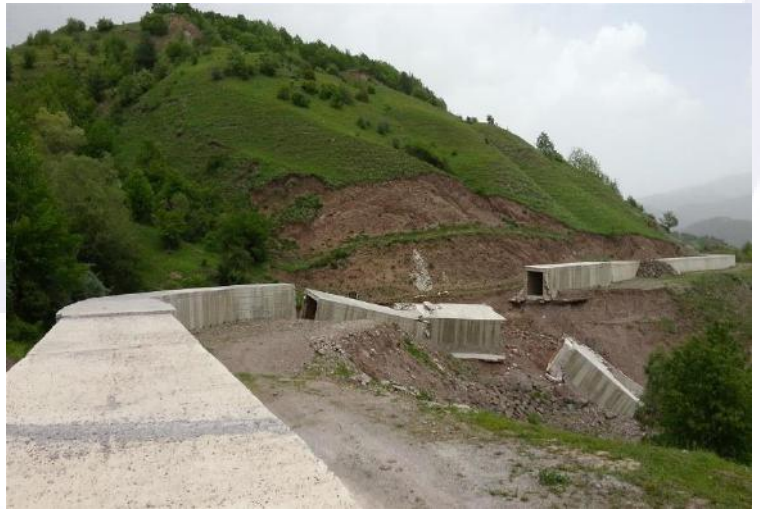
Őekil 16 - Toprak Kayması Neticesinde Hasar Gören İleti Kanalı
